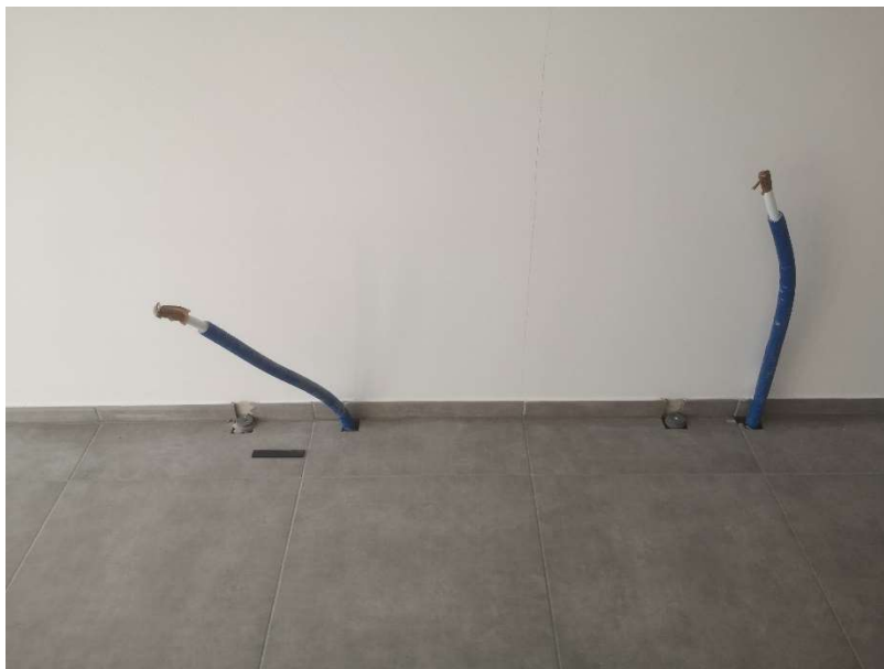
Predisposizioni a pavimento delle Adduzioni acqua fredda e scarico reflui
