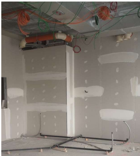
Vista interna laboratori a lavori in corso - Predisposizioni impiantistiche per espulsione aeriformi cappe chimiche
