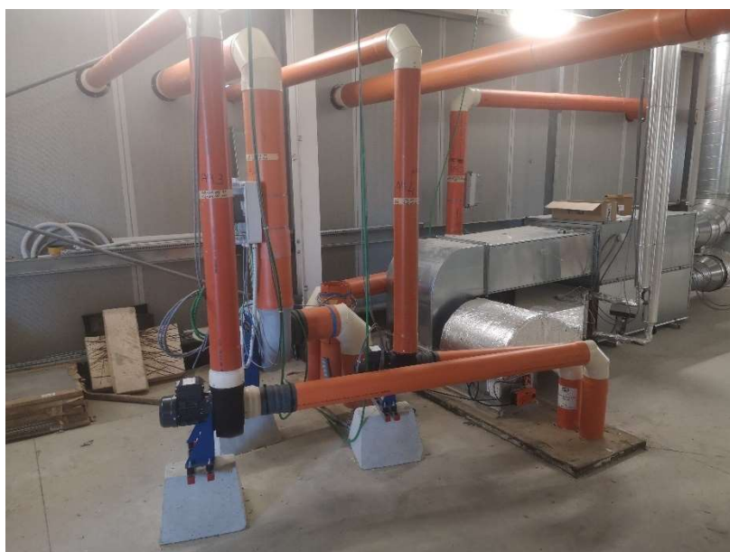
Vano tecnico piano secondo – Vista predisposizione estrazione circuiti Ar3, Ar4 e Br1
