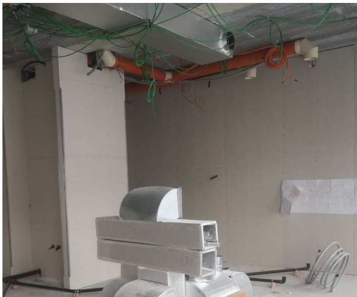
Vista interna laboratori a lavori in corso - Predisposizioni impiantistiche per espulsione aeriformi cappe chimiche
