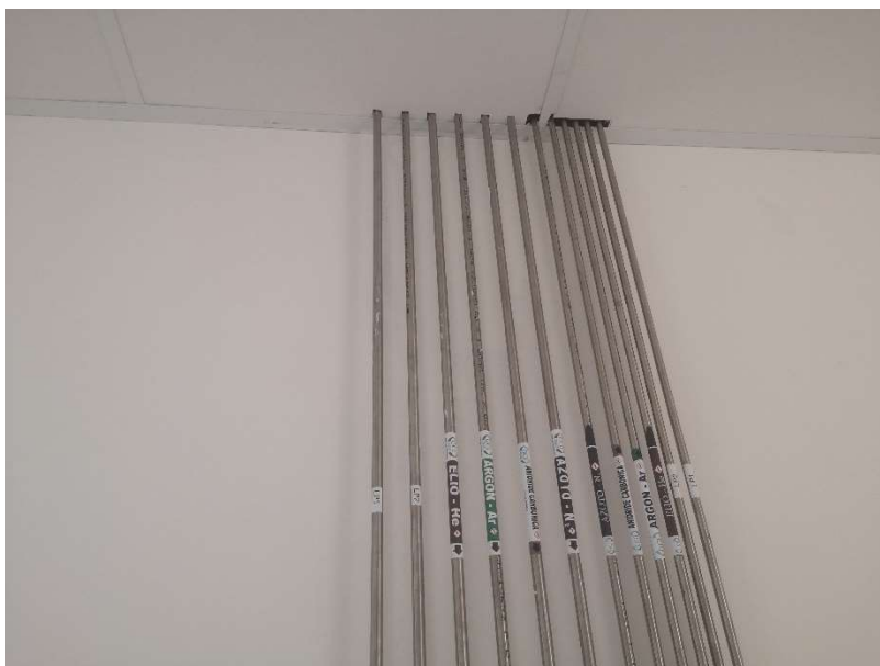
Vista predisposizione gas tecnici a soffitto corridoio di spina
