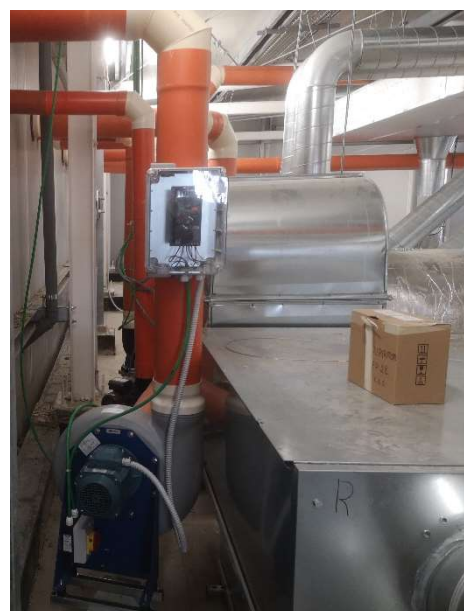
Vano tecnico piano secondo – Vista predisposizione estrazione circuiti Ar3, Ar4 e Br1
