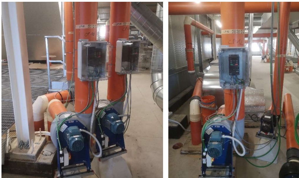
Vano tecnico piano secondo – Vista predisposizione estrazione cappe 10, 11 e 14
